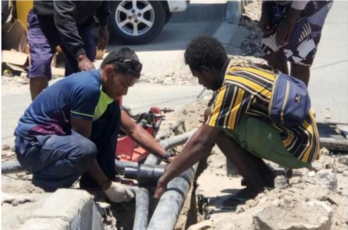
Petugas dari Dinas PUPR Kaimana saat melakukan pengecekan instalasi jaringan pipa air bersih di Kaimana (ANTARA/HO-Isabela Wisang)
