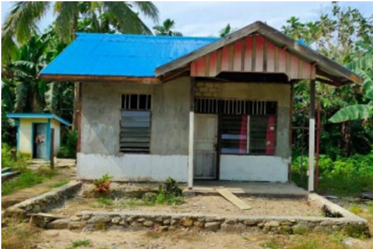
Foto: ANTARA/HO-Ditjen Perumahan Kementerian PUPR.
