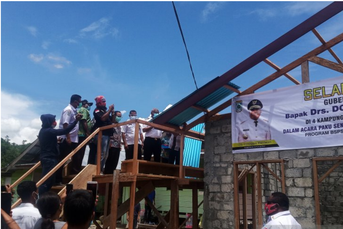
Gubernur Papua Barat Dominggus Mandacan mengawasi pemasangan atap pada program bantuan rumah swadaya di Kampung Kawanua, salah satu kampung persiapan di Manokwari, Rabu (30/9/2020) (Antara/Toyiban)
